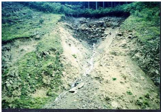
写真-2 崩壊地で見られる湧水(鳥取県林業試験場 小山敢氏提供)
