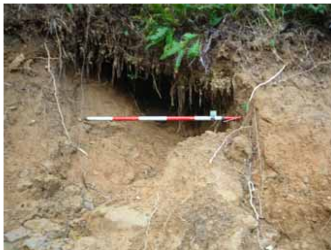
写真-3 崩壊地で見られたパイピングホール
