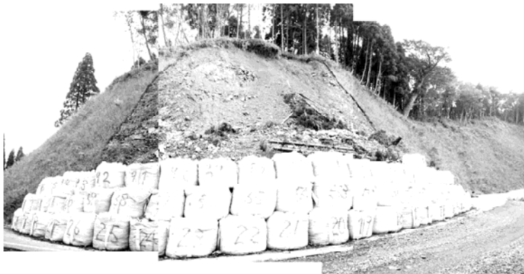
写真-16 林道 C で発生した法面崩壊
