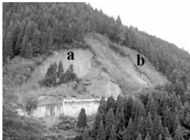
写真－14 林道 A で発生した法面崩壊
