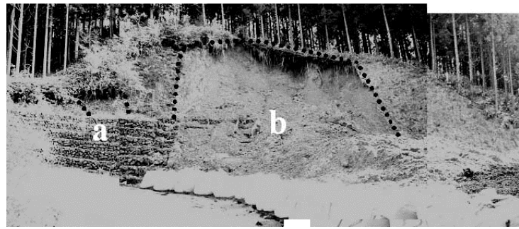
写真-15 林道 B で発生した法面崩壊
